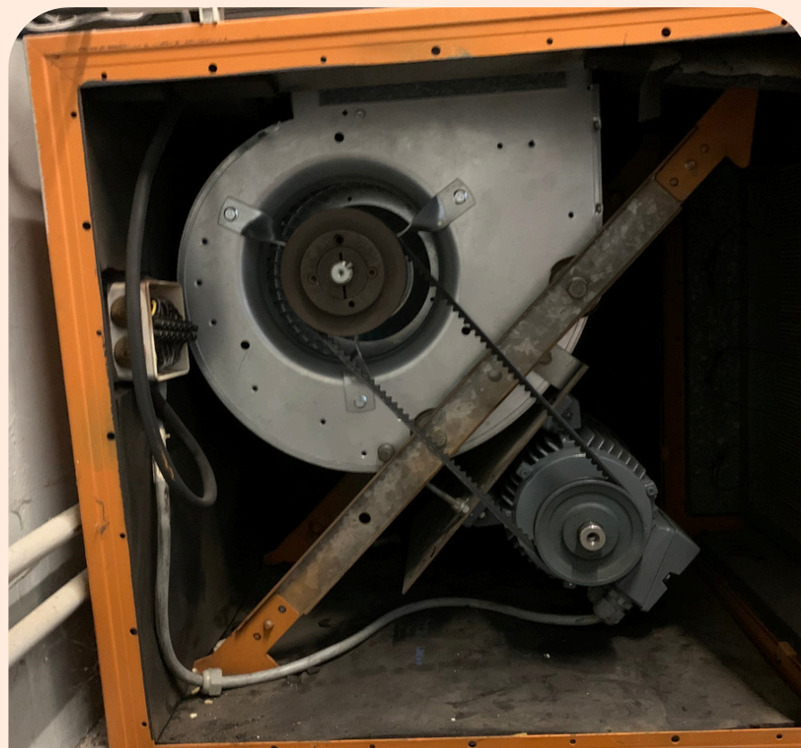
Remplacement de caisson VMC
