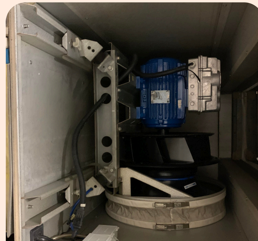
Remplacement moteur CTA blanchisserie
