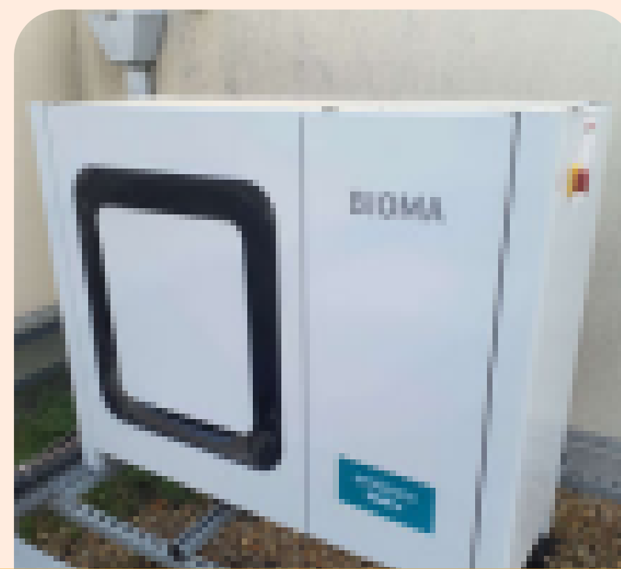
Réparation de la chambre froide négative
